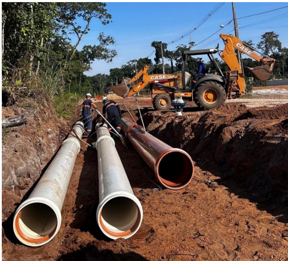
Figura 2 - Instalação da linha de recalque e emissário
