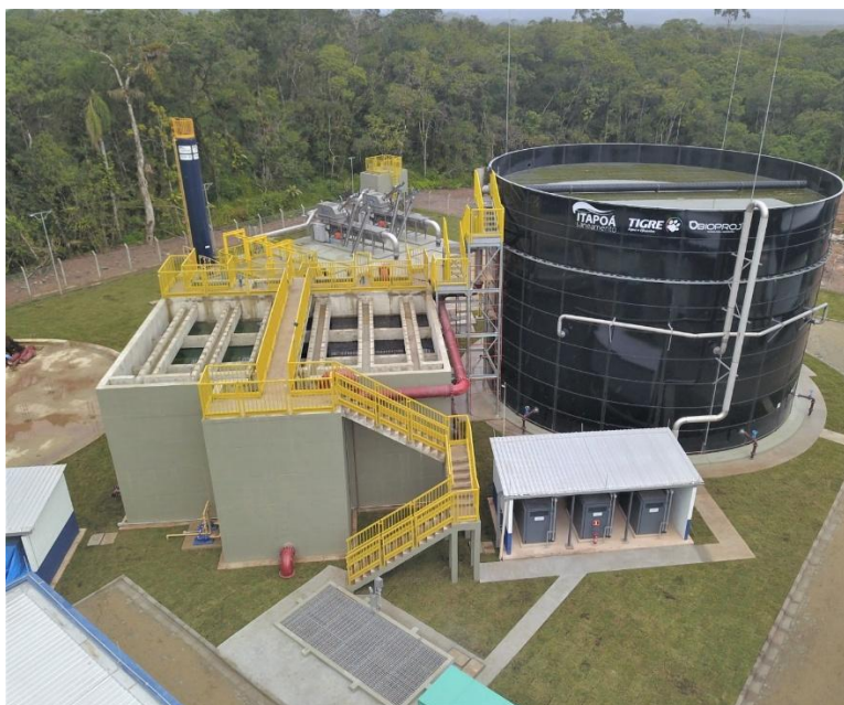
Figura 1 – Estação de Tratamento de Esgoto de Itapoá
